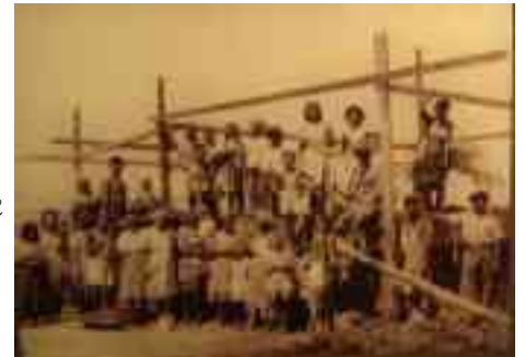
Abbildung 3 Hausbau in Rachitoasa, 1951 (DZM Ulm)
